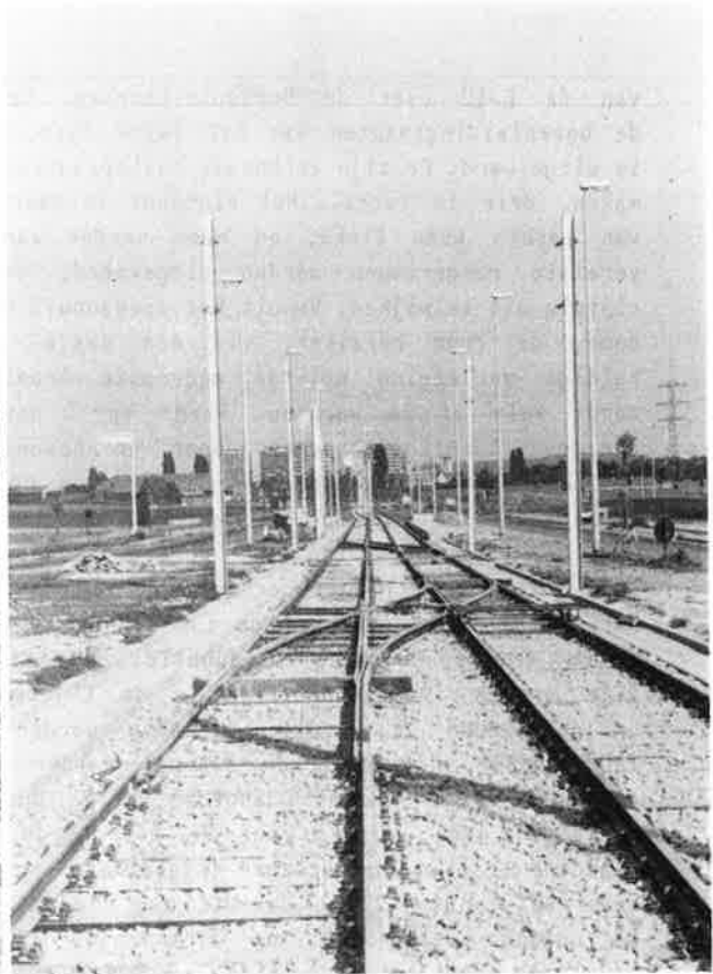
Twee opnamen, gemaakt op 5 sept.1981. De eerste geeft een beeld van de nieuwe tramlijn op de Lenniksebaan, en de tweede toont het eindpunt met de overloopwissels. Beide opnamen zijn genomen in de richting stadscentrum. Archieven Eigen Baan.
